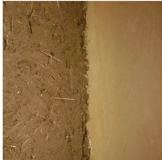
Revoques grueso y fino.
