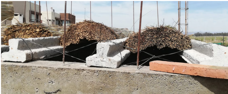
Construcción de una losa con viguetas pretensadas y fardos de cortadera. Desarrollo: Estudio Van-Gross.
