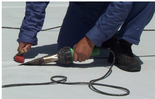
Soldadura de membrana impermeable de PVC.
