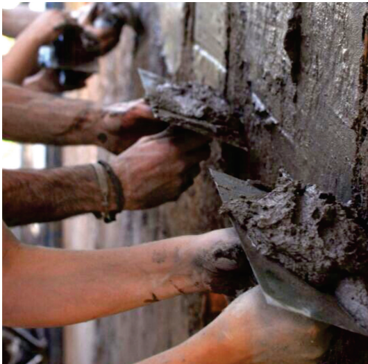
Aplicación de revoque fino con llana metálica.
