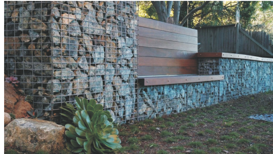
Gaviones de piedra y malla metálica.
