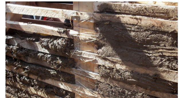
Relleno de quincha húmeda con paja de trigo y barro.
