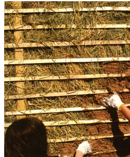
Revoque de carga sobre quincha seca con listones horizontales. Fuente: Arq. Gernot Minke.
