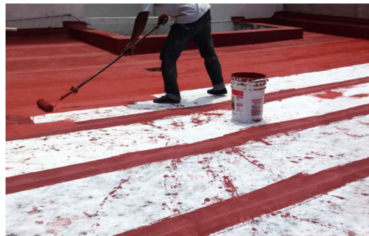
Membrana asfáltica geotextil y pintura elastomérica poliuretánica.
