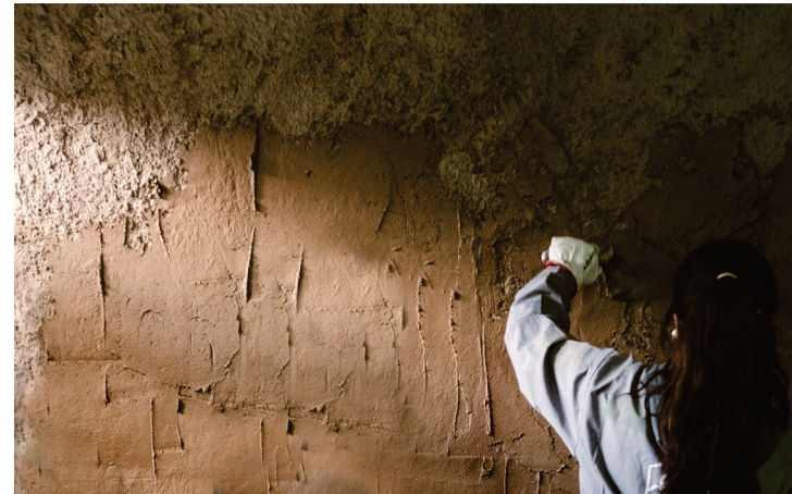
Aplicación de revoque con cuchara.
