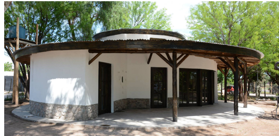
Vivienda modelo en tierra cruda y quincha mejorada en el Museo Histórico y Natural de la ciudad de Tulumaya, provincia de Mendoza. El Departamento Lavalle promueve pautas constructivas que aportan seguridad estructural, regulando la construcción y restauración en tierra. www.lavalle Mendoza.gov.ar
