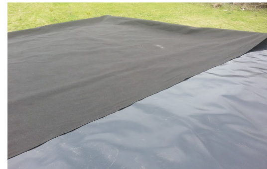
Manto geotextil y polietileno de alta densidad, 800 µm.
