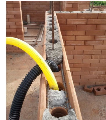
Refuerzo horizontal con BTC de media caña.
