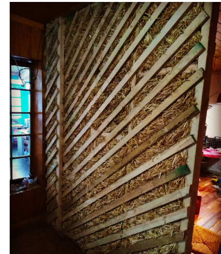
Tabique interior de quincha seca con listones en diagonal.
