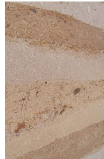
Muro de tapial y sobrecimiento de hormigón armado.
