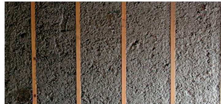
Proyección de celulosa sobre muro de entramado liviano de madera.
