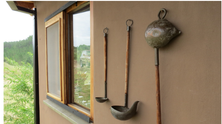
Detalle de revoque fino exterior. Umepay, Córdoba.
