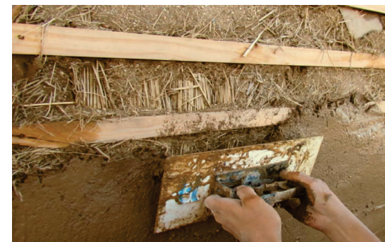
Aplicación de revoque con llana metálica.
