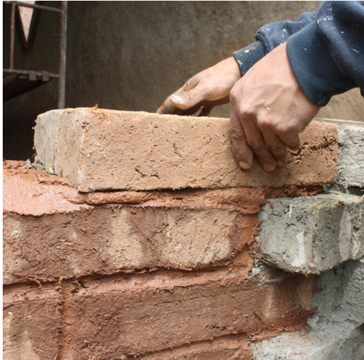
Construcción con adobes.
