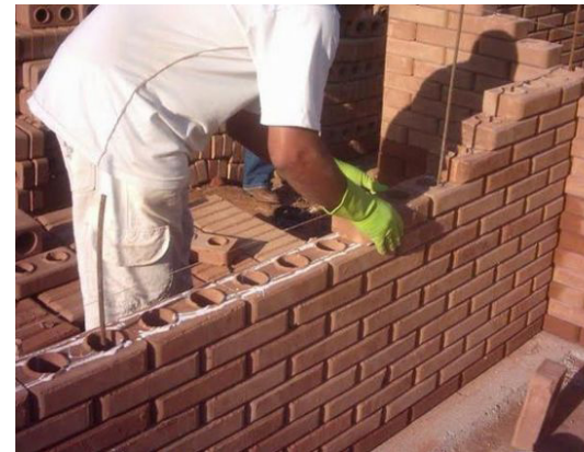
Construcción con BTC.
