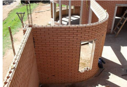
Versatilidad del BTC para materializar muros curvos.
