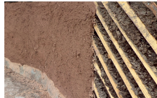
Revoque de carga sobre quincha húmeda.
