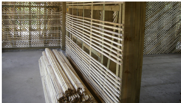
Estructura principal y secundaria de madera aserrada.
