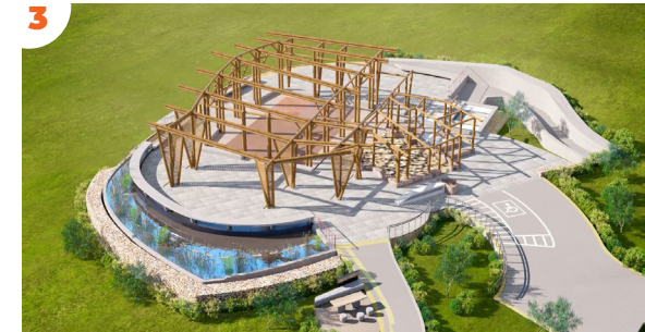
3 Pórticos de dos sectores, solados interiores y exteriores y rampas.
