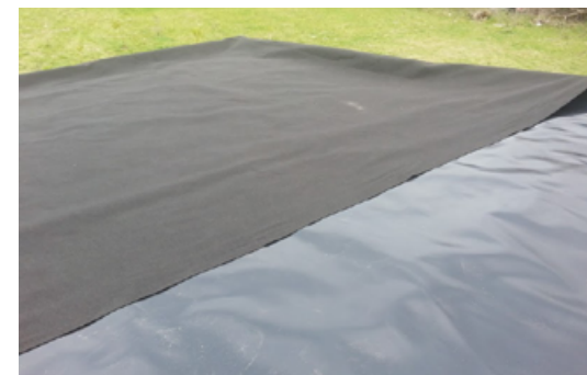
Manto geotextil y polietileno de alta densidad, 800 \mu\text{m} .
