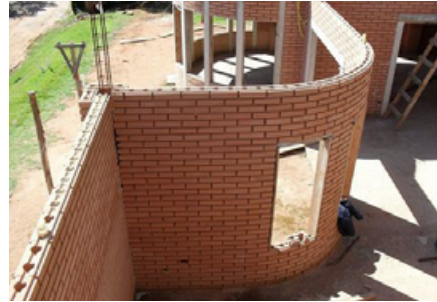
Versatilidad del BTC para materializar muros curvos.
