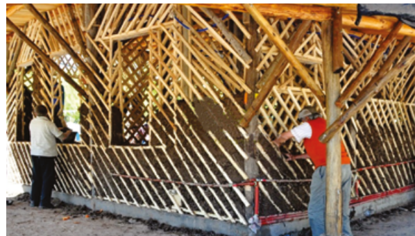
Construcción de la oficina de turismo municipal de Coronel Belisle, Río Negro en el marco de un proyecto participativo y capacitación teórico práctica a personal municipal y vecinos.
