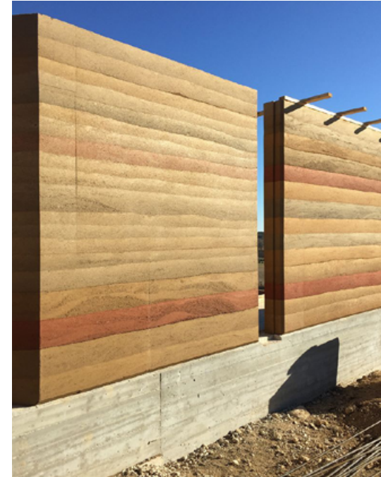
Muro de tapial y sobrecimiento de hormigón armado.
