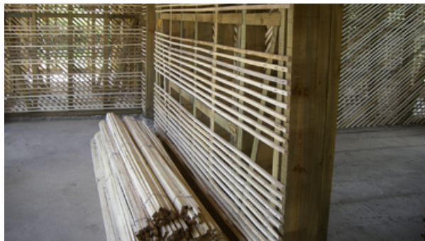
Estructura principal y secundaria de madera aserrada.
