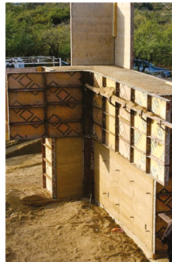
Proceso constructivo de una vivienda de tapial en Luján de Cuyo, Mendoza. Encofrado de madera y apisonado manual. Fuente: Ing. Daniel García Gei.
