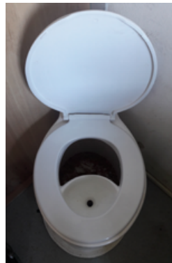
Taza separadora de inodoro seco. Nótese el embudo frontal que colecta la orina.
