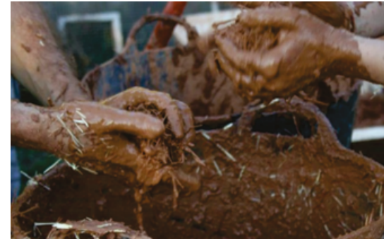
Mezcla de barro y fibra para revoque.
