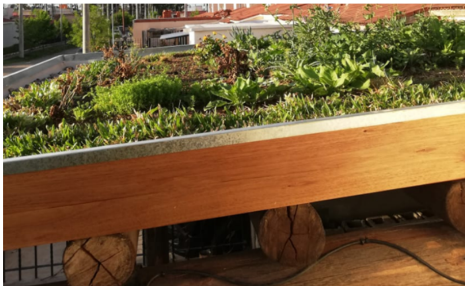
Techo vivo sobre estructura de postes de eucalipto.
