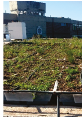
Vista general del sistema instalado en la UCC.
