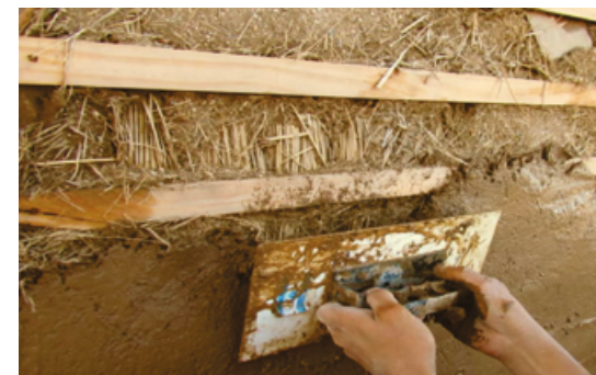
Aplicación de revoque con llana metálica.
