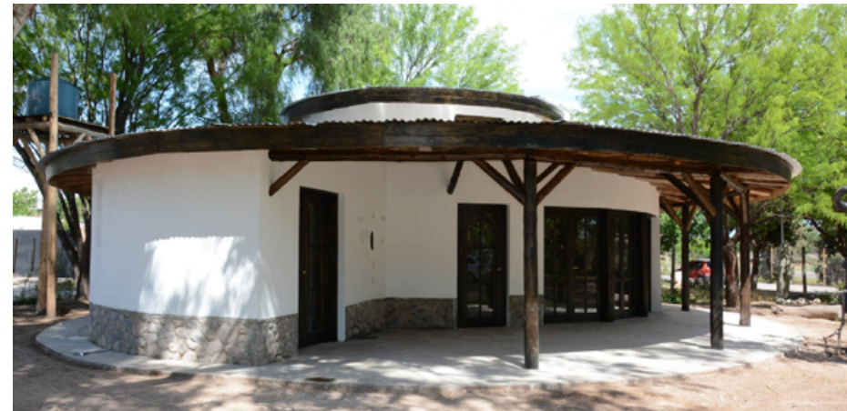
Vivienda modelo en tierra cruda y quincha mejorada en el Museo Histórico y Natural de la ciudad de Tulumaya, provincia de Mendoza. El Departamento Lavalle promueve pautas constructivas que aportan seguridad estructural, regulando la construcción y restauración en tierra. www.lavalle Mendoza.gov.ar
