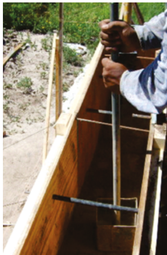
Proceso constructivo de una vivienda de tapial en Luján de Cuyo, Mendoza. Encofrado de madera y apisonado manual. Fuente: Ing. Daniel García Gei.
