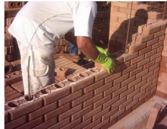
Construcción con BTC.
