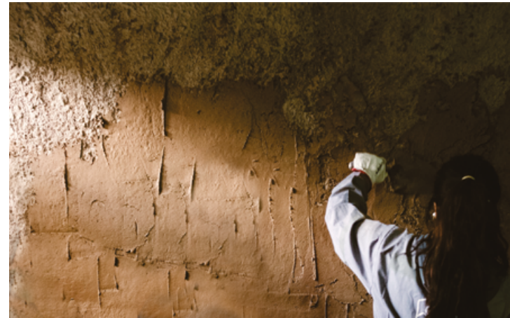
Aplicación de revoque con cuchara.
