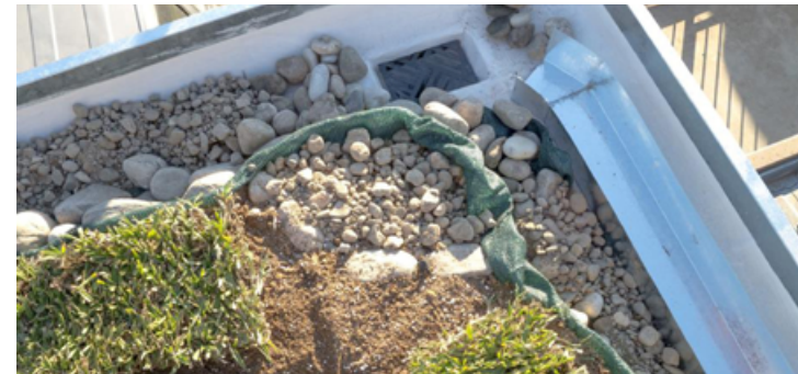
Techo vivo transitable con césped, malla plástica y piedras de diferentes tamaños para el drenaje.
