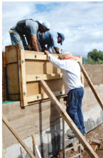
Proceso constructivo de una vivienda de tapial en Luján de Cuyo, Mendoza. Encofrado de madera y apisonado manual. Fuente: Ing. Daniel García Gei.
