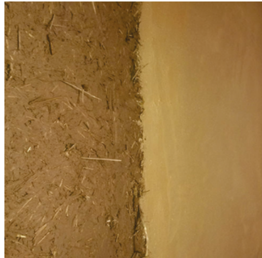
Revoques grueso y fino.
