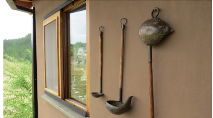
Detalle de revoque fino exterior. Umepay, Córdoba.
