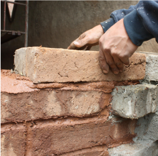
Construcción con adobes.
