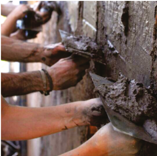
Aplicación de revoque fino con llana metálica.
