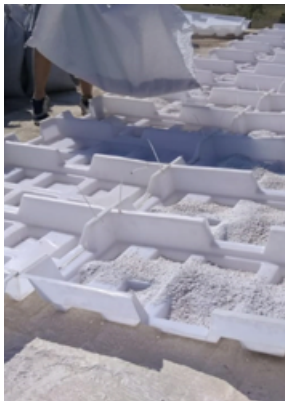
Bateas plásticas con material de drenaje.
