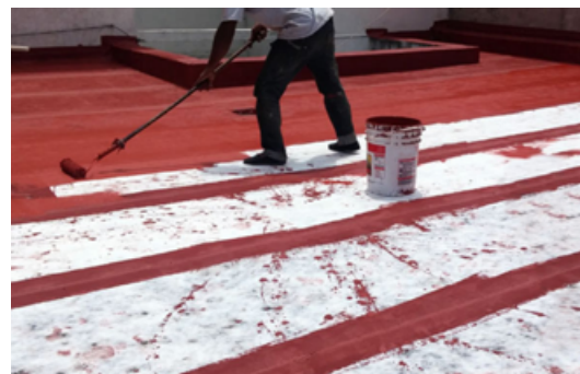
Membrana asfáltica geotextil y pintura elastomérica poliuretánica.
