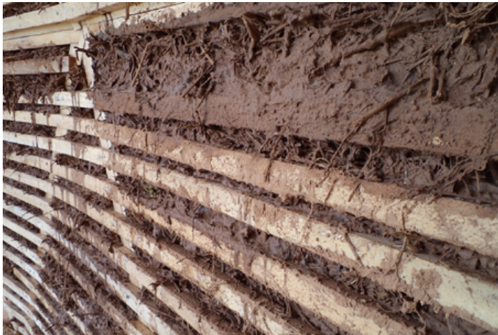
Relleno de quincha húmeda con paja de trigo y barro.
