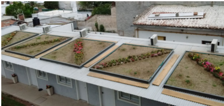
Techo vivo sobre chapa acanalada construido por alumnos del TABI en la municipalidad de Alta Gracia, Córdoba.
