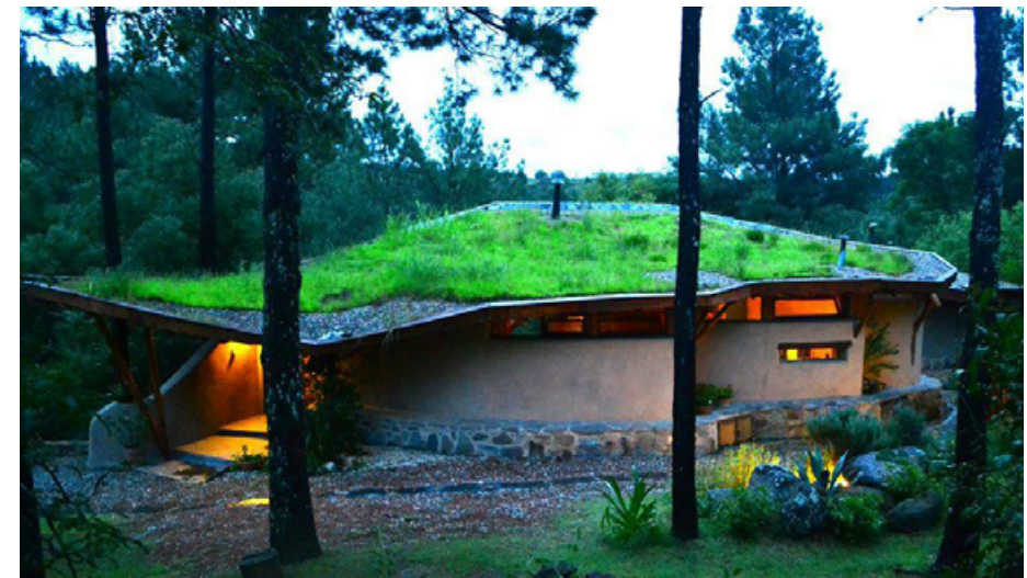
Techo vivo en una bioconstrucción del complejo "La Anita" en Intiyaco, Córdoba.
