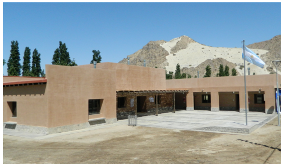
Escuela primaria N° 299 en Tatón, Catamarca. Construida con muro doble de bloques de tierra comprimida por el Ministerio de Obras Públicas provincial con fondos del Ministerio de Educación de la Nación.
