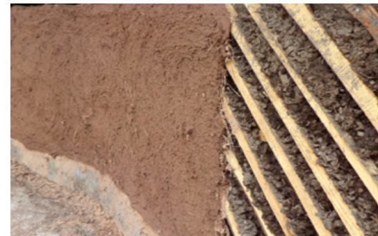
Revoque de carga sobre quincha húmeda.
