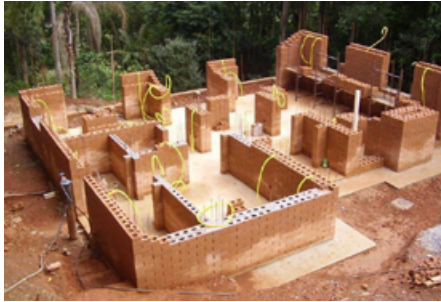
Obra en proceso, muros simples, dobles y cañerías eléctricas.
