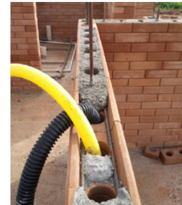
Refuerzo horizontal con BTC de media caña.
