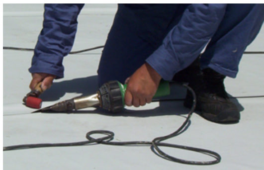
Soldadura de membrana impermeable de PVC.
