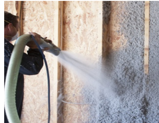
Proyección de celulosa sobre muro de entramado liviano de madera.
