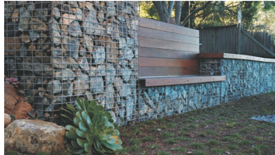
Gaviones de piedra y malla metálica.
