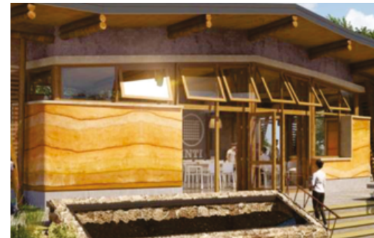
Render del muro de tapial en la fachada Norte del SUME
