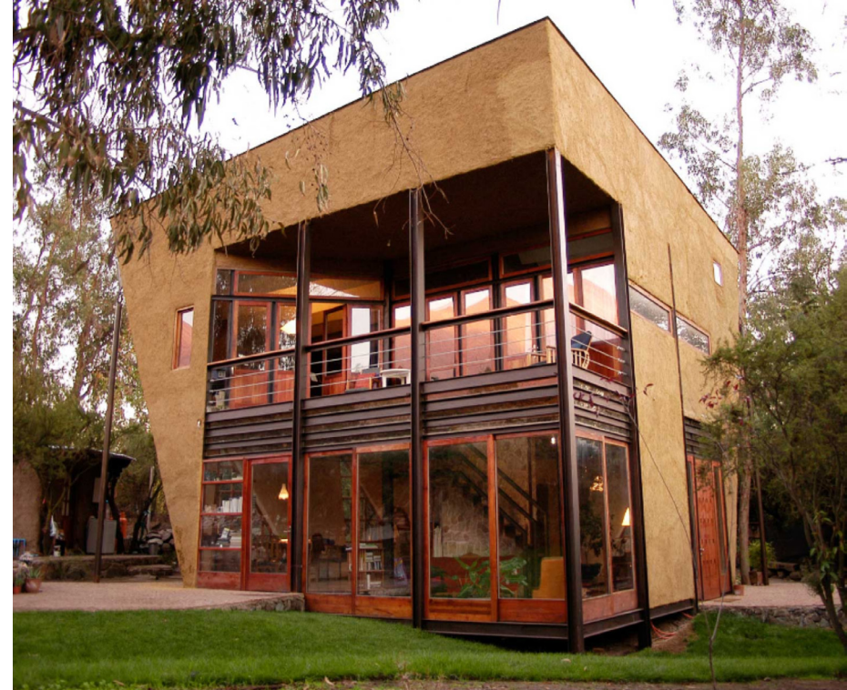
La quincha metálica ha permitido explorar con el uso de mallas electrosoldadas. Fuente: https://marcelocortes.cl/
