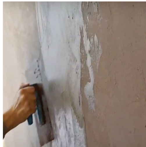
Proceso de revoque fino con llana metálica.
