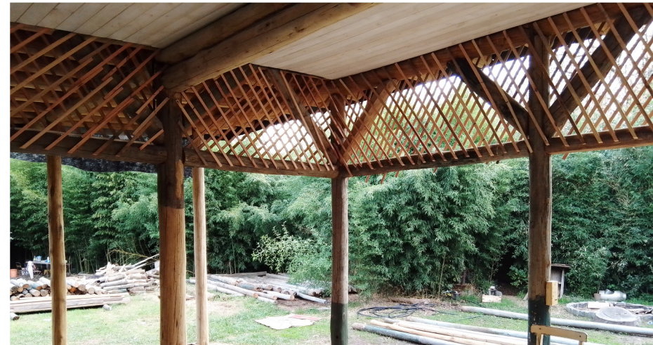
Sistema de poste y viga ( Eucalyptus grandis ). Se observan columnas, vigas simples, vigas dobles, nudos con puntales de arriostre y listones para contener el relleno. Escobar, provincia de Buenos Aires. Foto: Alejandro Dominguez.
