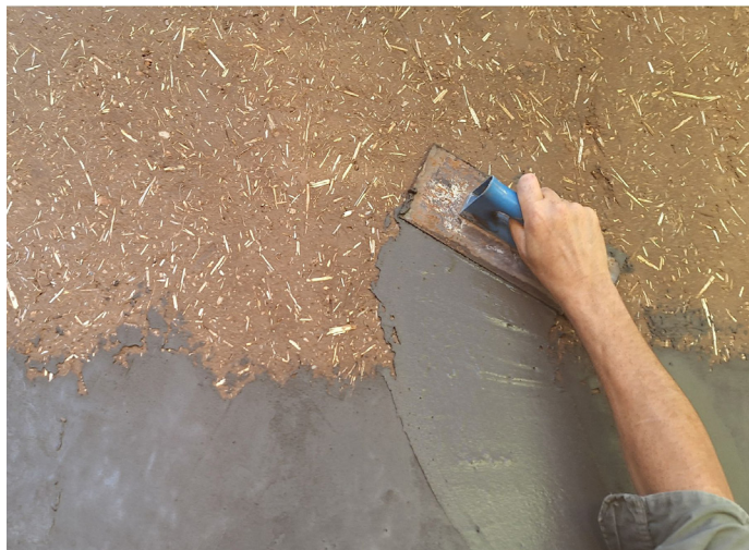
Proceso de revoque prefino con llana metálica.
