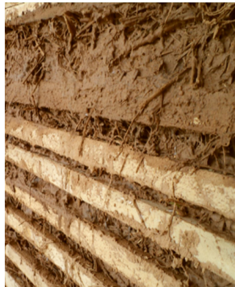
Relleno de quincha pesada.
