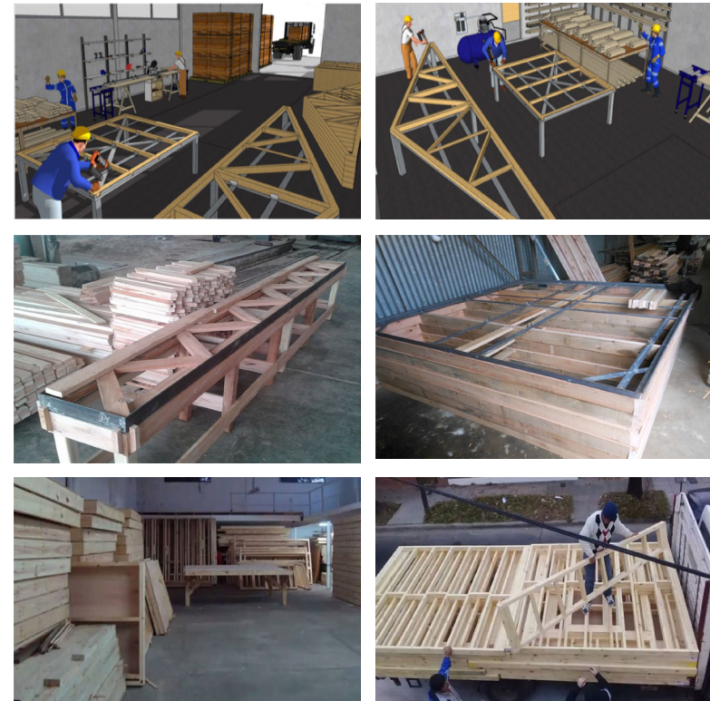
Fabricación de piezas-parte en mesas-molde y traslado a obra.
