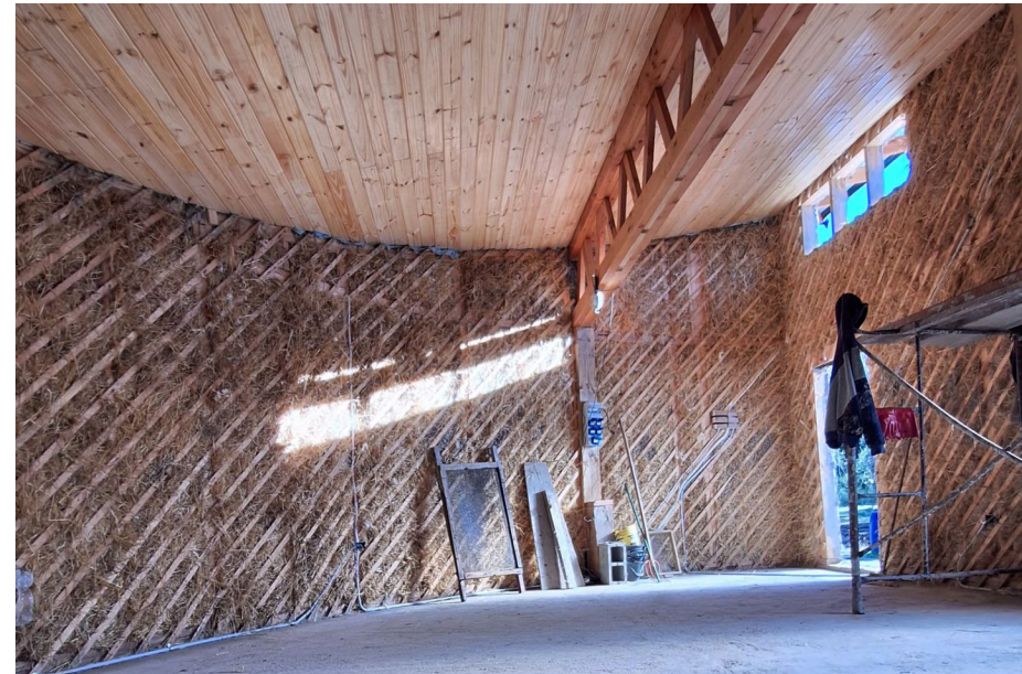
Quincha seca de rastrojo de trigo en bastidores de 2" por 6". Densidad: 60 kg/m 3 . Estudio de música en Radal, Lago Puelo, Chubut. Arq. Rodolfo García Núñez y Arq. Emanuel Rocha.
