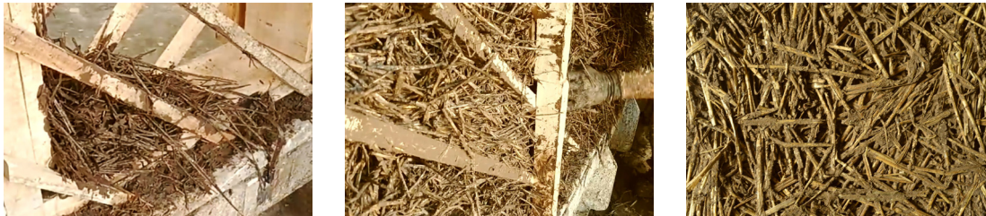
Proceso de relleno manual del muro.
