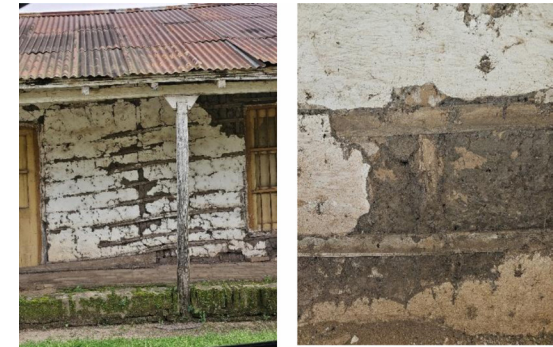
Viviendas de quincha con estructura tacuara guazú de Loreto, Corrientes. Foto: Federico García Martínez.
