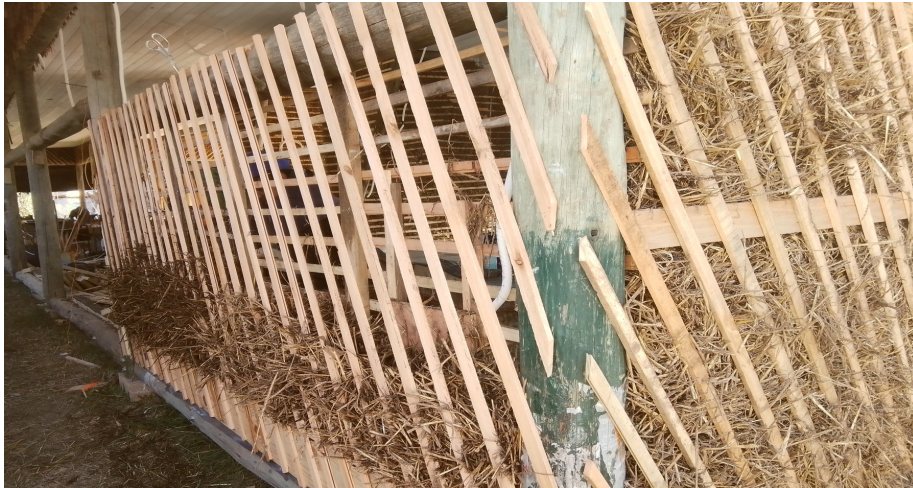
Estructura principal de postes rollizos de eucalipto. Relleno de quincha liviana (tierra y paja de trigo), con un espesor de 20 cm y una densidad de 400 kg/m 3 . Escobar, provincia de Buenos Aires. Foto: Alejandro Domínguez.
