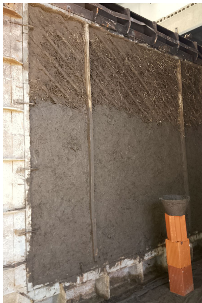
Proceso de revoque grueso.
