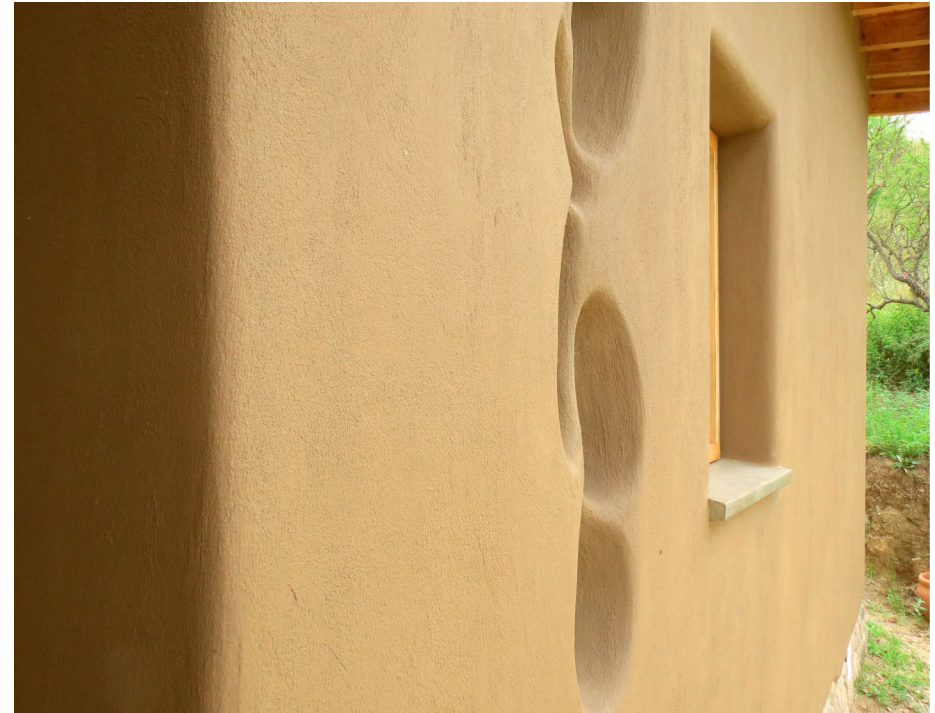
Revoque de tierra exterior con protección de alero.
