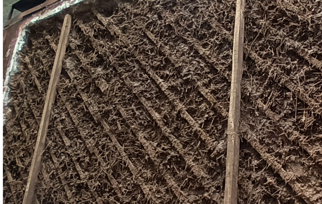
Muro con imprimación y fajas de madera temporalmente atornilladas a la estructura.
